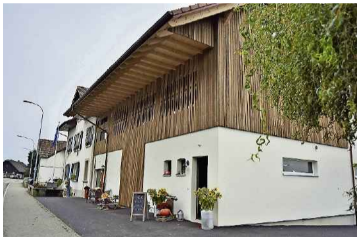
Auf den Grundmauern der abgebrannten Scheune ist der neue Anbau entstanden, der die vier Zimmer des B&Bs beheimatet.
